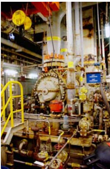
Gasskompressoren på TCP2
